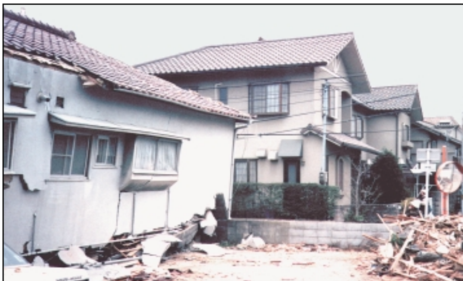
Effets du tremblement de terre de Kobe (Japon) en 1995 : trois maisons à ossature de bois de style canadien non endommagées (à l'arrière-plan) et une maison plus ancienne détruite (à l'avant-plan).
